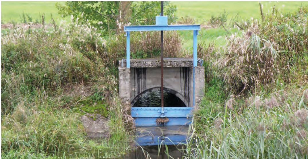
Zastawka na rowie umożliwia piętrzenie i regulację poziomu wody. Odpowiedni stan techniczny tego urządzenia wpływa na stosunki wodne siedliska. (fot. Z. Kowalewski)
