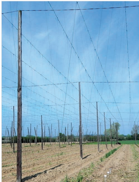
Fot. 1. Konstrukcja nośna chmielnika
