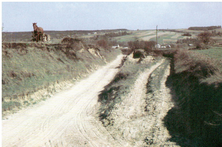
Fot. 2. Grunty zdewastowane przez wąwozy drogowe
