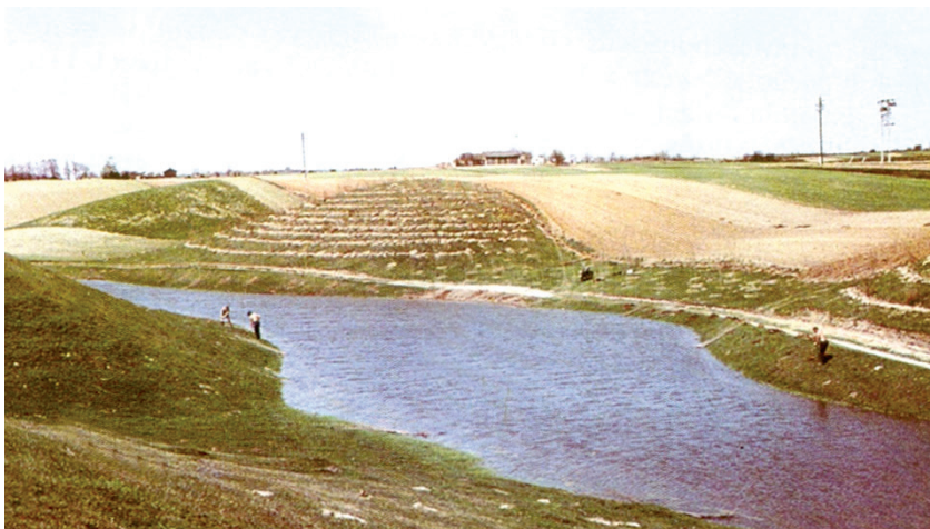
Fot. 6. Zagospodarowanie wąwozu zbiornikiem retencyjnym
