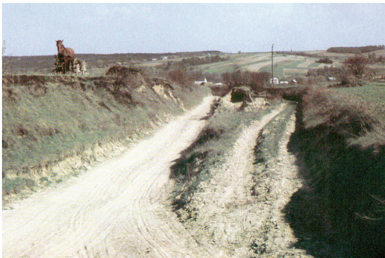
Fot. 2. Grunty zdewastowane przez wąwozy drogowe
