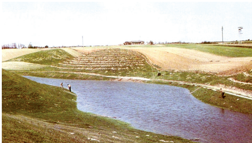
Fot. 6. Zagospodarowanie wąwozu zbiornikiem retencyjnym
