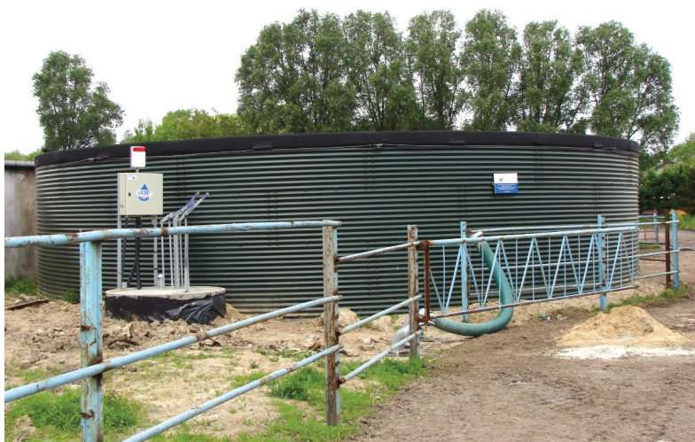
Fot. 4.2.1. Zbiornik na gnojowicę z blachy falistej zabezpieczonej warstwą ochronną z każdej strony (fot. P. Nawalany)
